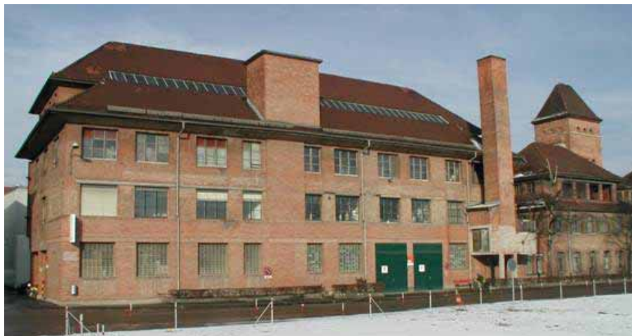
Feuerwehrgebäude der Rhodia Industrial Yarns AG.
